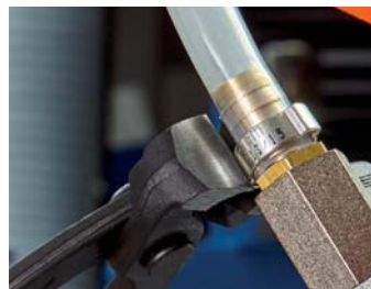
10 98 I220: Abdichten Schlauchanschluss an Zentralschmierung
