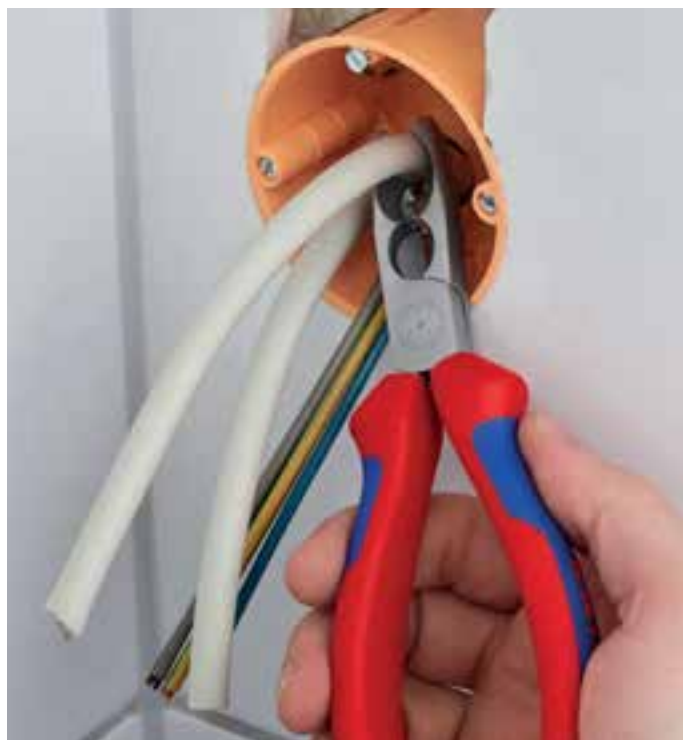
Spelatura guaina anche in profondità nella cassetta di derivazione a incasso
